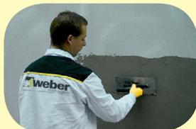
Při stěrkování se připravená hmota nanáší na podklad nerezovým hladítkem.
