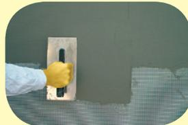
Pokud se vytváří základní vrstva, vkládá se skleněná síťovina do předem nanesené vrstvy stěrkové hmoty a vtlačí se dovnitř zahlazením nerezovým hladítkem směrem od středu ke krajům. Skleněná síťovina je v 1/3 tloušťky základní vrstvy od vrchu.
